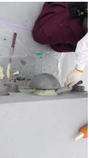
各所金物補修及びサビ止め
