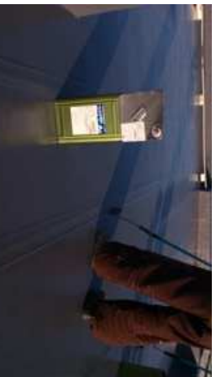
遮熱塗料塗布(日本特殊塗料 ハテサーモ)
