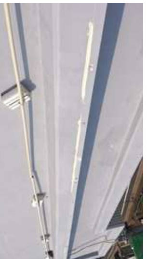
各所防水押え金物固定及びシーリング
