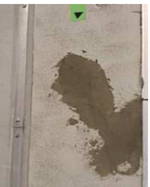
モルタル補修
