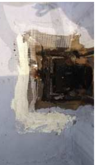
コンクリート埋設の3枚目周りの防水補修
