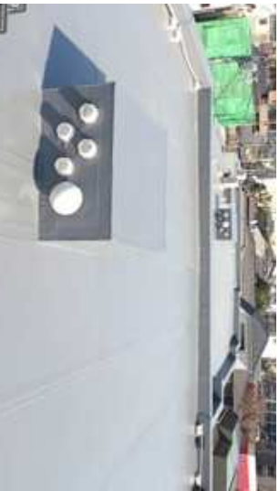
遮熱塗料塗布完了
