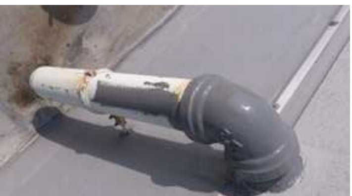
コンクリート埋設の3枚目周りの防水補修
