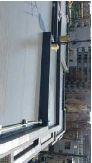
遮熱塗料塗布完了
