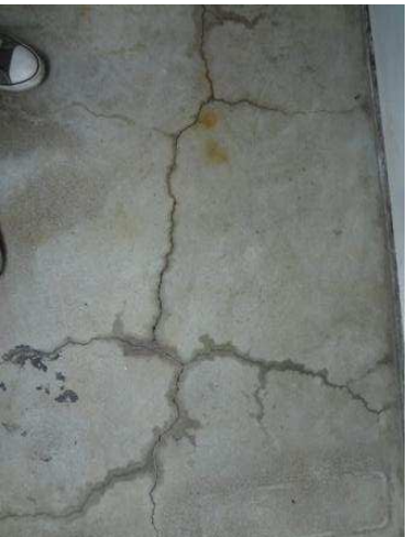
ひび割れ部（濡れている様に見える水跡）
