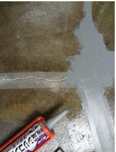
ひび割れ部（濡れている様に見える水跡）
