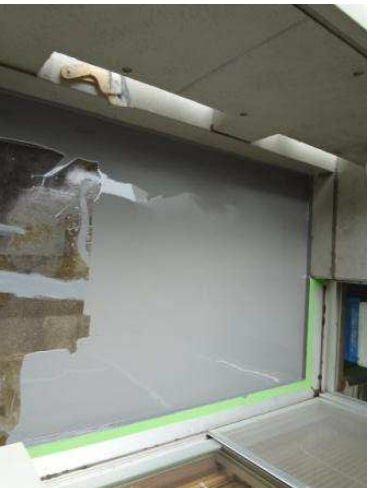
ひび割れ変成シリコンシーリング
