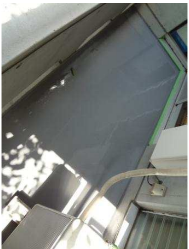
7月28日 カテナ塗布防水補修後
