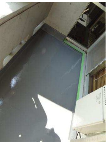
トッポコート施工 (乾燥確認後養生撤去・エアコン室外機位置復旧)
