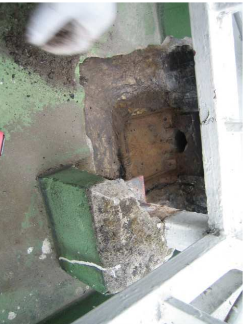
3階 保護モルタル撤去後
