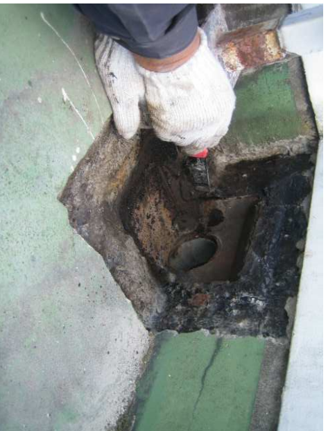
屋上 保護モルタル撤去後
